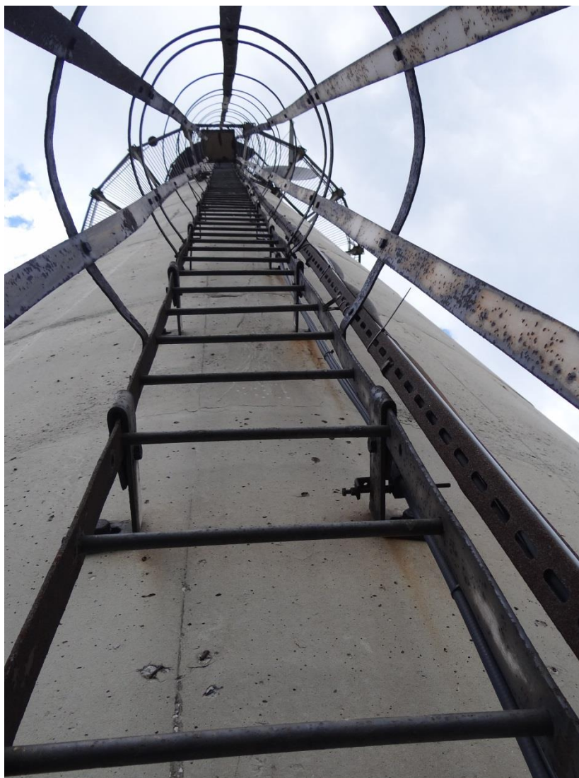
zdz. nr 1 – widok drabinki z zamocowanym ceownikiem jako trasą kabli
